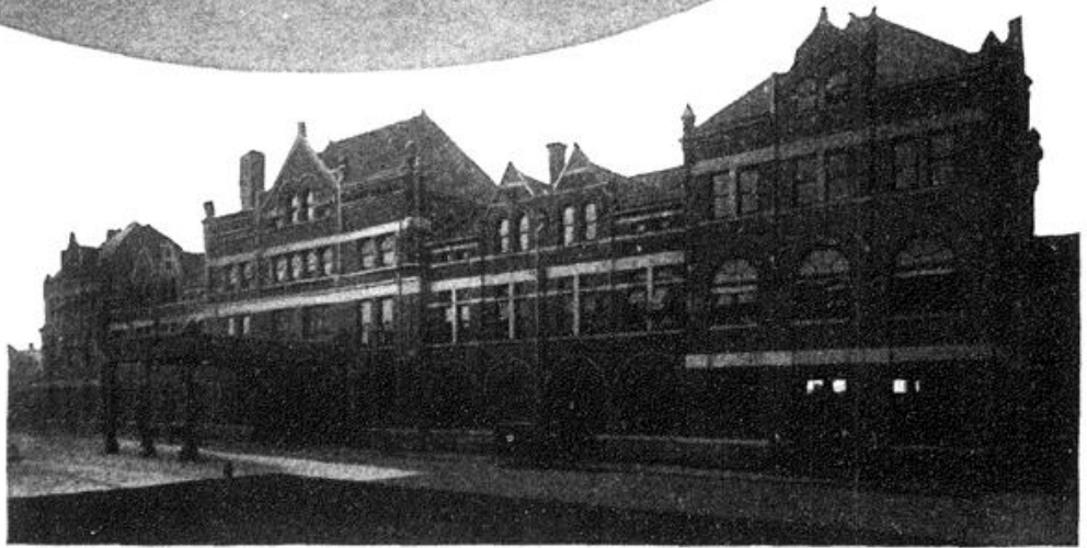
L. & N. Station Pensacola, Fla.
