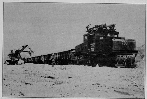
FIGURE 16.- TRANSPORTING WASTE AT AN OPEN-CUT COPPER MINE WITH A COMBINATION TROLLEY STORAGE-BATTERY LOCOMOTIVE
